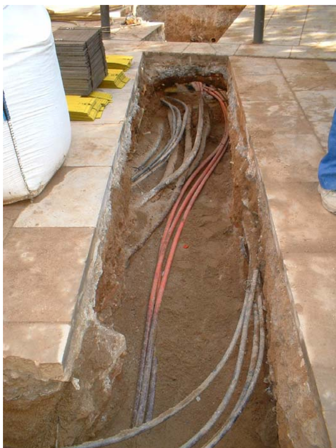
Fotografia 22: Tram parcial de la Rasa 500 amb altres serveis elèctrics anteriors.
