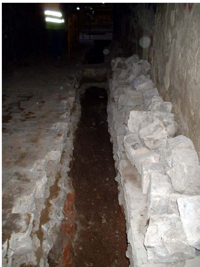
Fotografia 34: Tram parcial de la Rasa 800.
