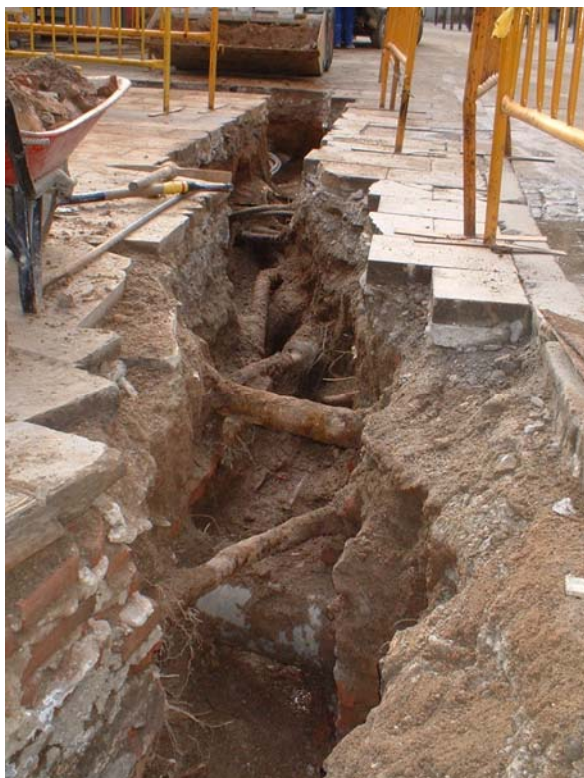
Fotografia 27: Tramo parcial de la Rasa 600 amb la presència de nombrosos serveis anteriors.
