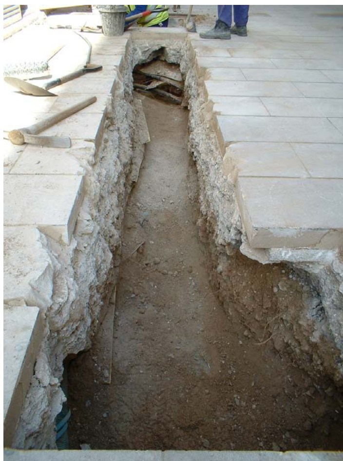
Fotografia 8: Tram parcial de la Rasa 300.
