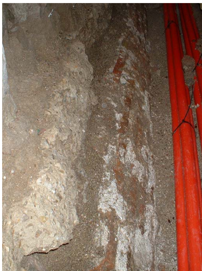
Fotografia 36: Volta de la claveguera actual que passa pel centre del carrer
