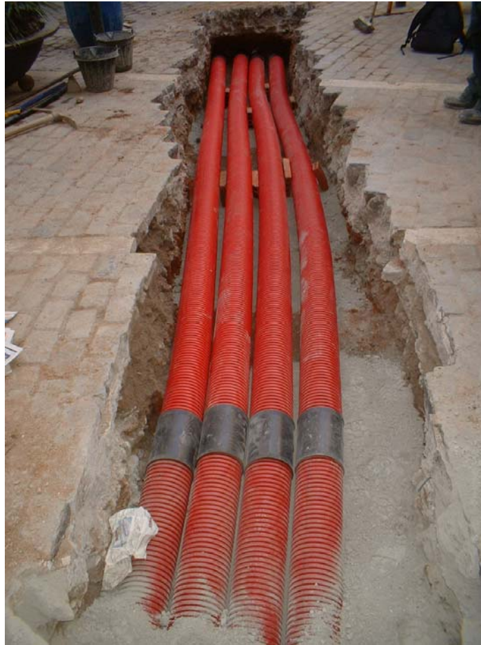
Fotografia 19: Creuament del carrer de les Basses de Sant Pere (Rasa 400) amb els tubulars col·locats.
