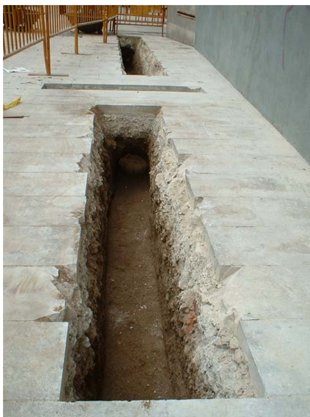
Fotografia 2: Tram parcial de la Rasa 100.
