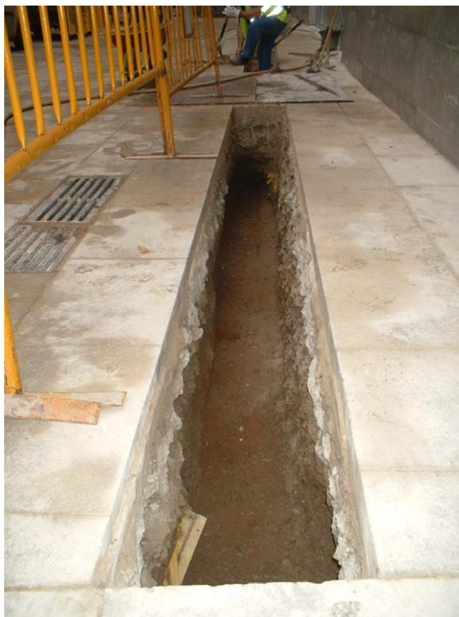
Fotografia 5: Tram parcial de la Rasa 200.
